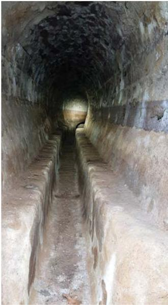
Les travaux d'aménagement des chemins du Cheix et des Fontaines ont mis à jour le canal historique d'alimentation des fontaines de notre commune. Il s'agit d'un canal bâti de 1 m 60 de hauteur et 80 cm de largeur, qui conduisait l'eau depuis les sources de Pagnat à Saint-Saturnin. Une pompe type « bélier » permettait de franchir l'important dénivelé depuis le niveau de la Veyre. Le fonctionnement de ce système d'élévation d'eau, dépend uniquement de la force motrice de l'eau, sans
